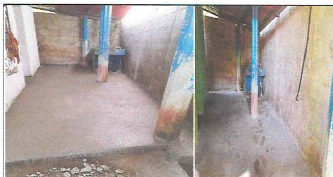
Foto 4: Sustitución de torta rustica por torta lisa en cocina.
