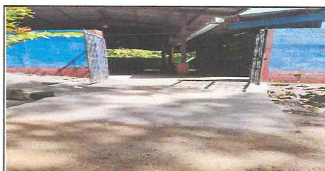
Foto 10: Reparación de rampade acceso en la entrada al establecimiento.
