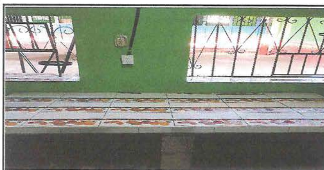
Foto 11: Implementación de azulejo en mesa de cemento y mostrador de cocina.
