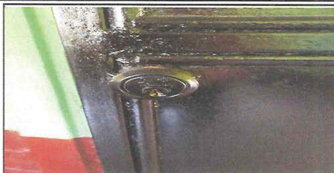
Foto 2: Sustitución de chapas en pueretas de metal
