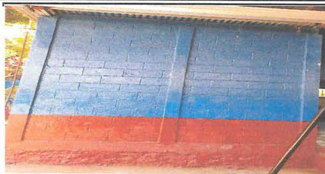
Foto 13: Aplicación de pintura en paredes exteriores de salones.
