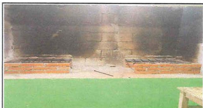
Foto 9: Implementación de hornillas de ladrillo con parrillas de hierro.
