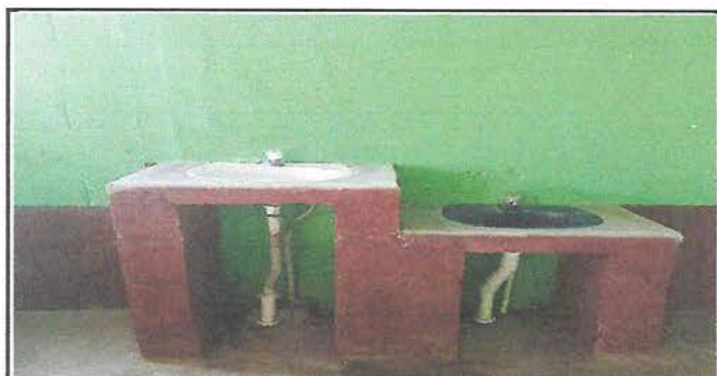
Foto 6: Implementación de mesa de cemento para lavamanos. Según acta No.18-2024
