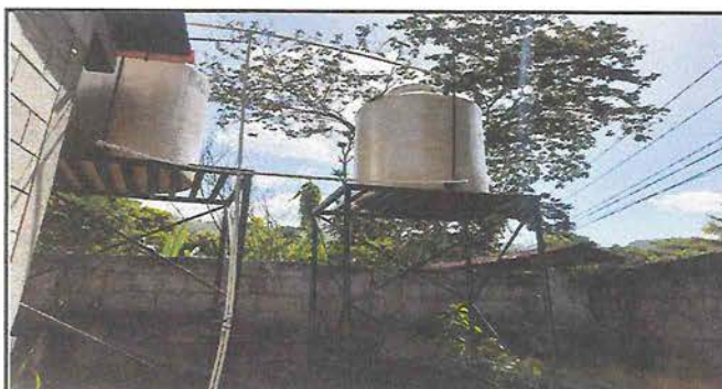
Foto 15: Construcción de torres para tinacos con sus tinacos.
