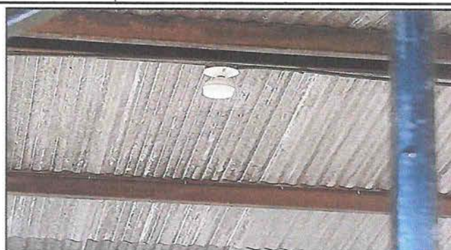
Foto 8: Su.stitución de lamparas flourecentes por focos ahorradores de energia
